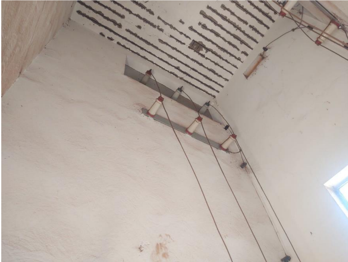
Figura 8. Barramento de cobre, isolador pedestal e para raio de proteção (saída)
