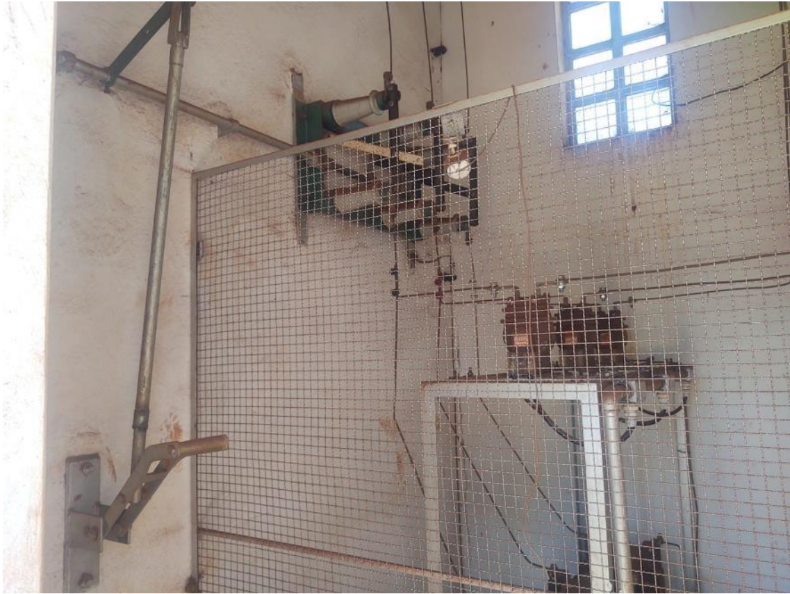
Figura 6. Barramento conexão em cobre e isolador pedestal
