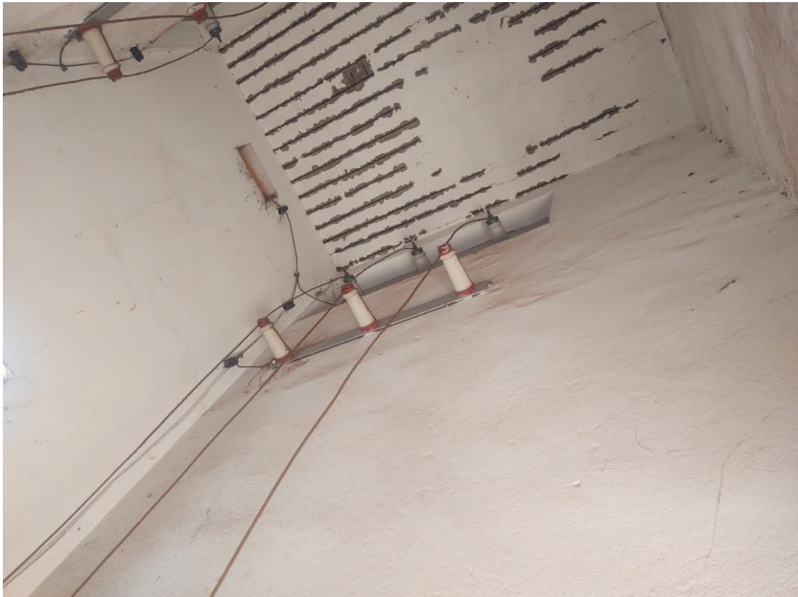
Figura 8. Barramento de cobre, isolador pedestal e para raio de proteção (saída)
