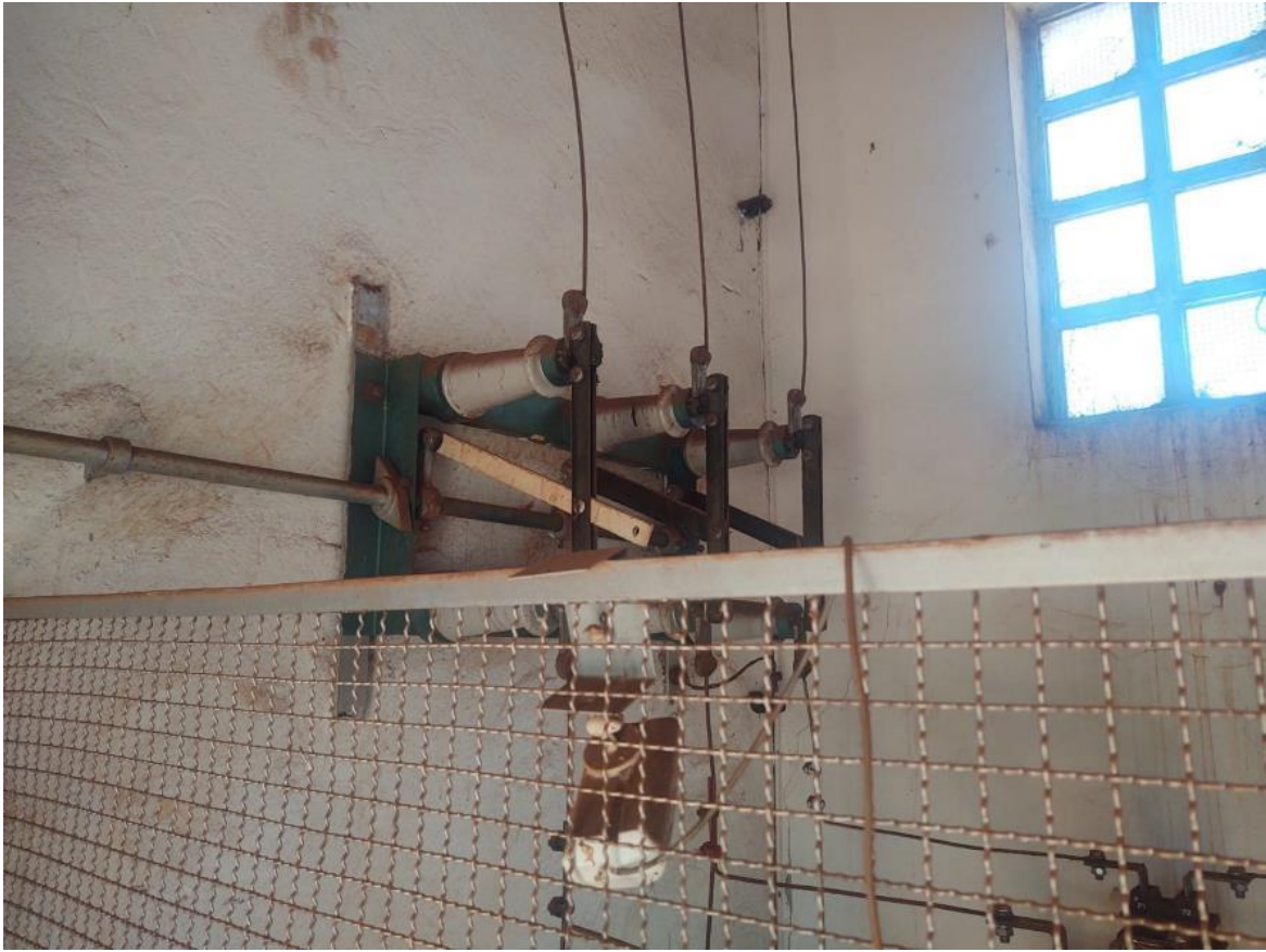
Figura 9. Detalhe chave seccionamento manual
