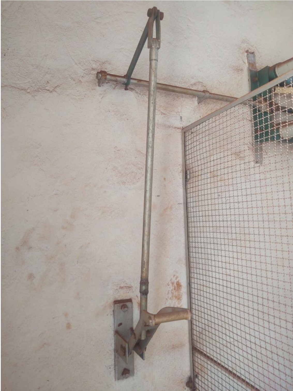
Figura 3. Alavanca para manobra manual chave seccionamento
