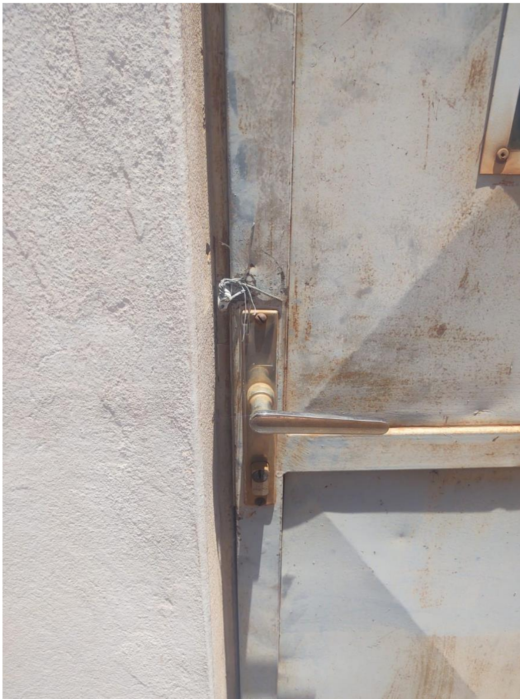
Figura 1. Porta metálica de acesso
