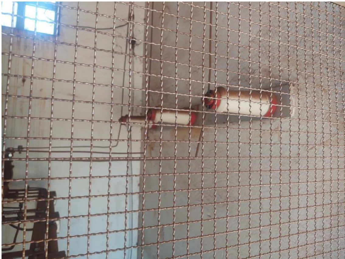
Figura 6. Barramento conexão em cobre e isolador pedestal
